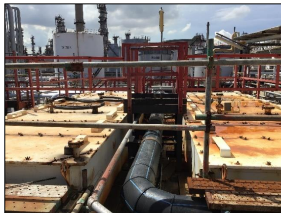
รูปที่ 2-8 ระบบ API Separator
